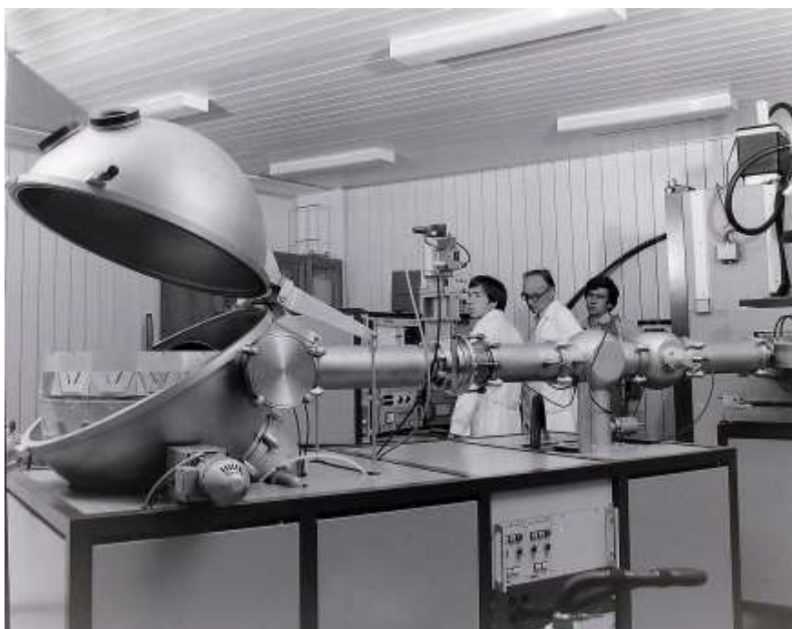
Implantátor MBP 200 fy Balzers. Uprostřed doc. Pelikán, vpravo Ing. Jirásek
